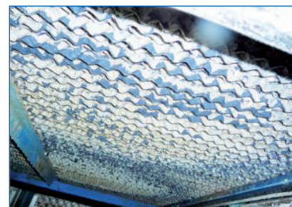
Kalkbildung (Scaling) auf Kühlwaben
